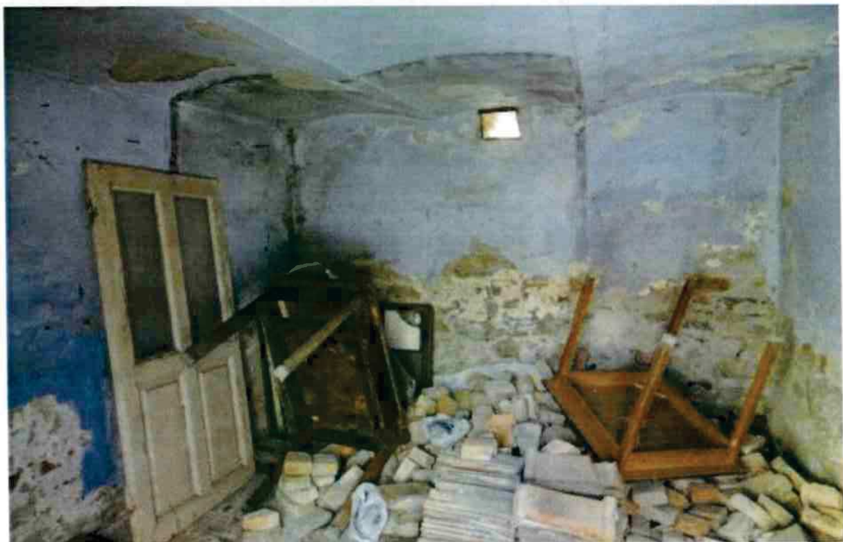
Obr. 6. Interiér jednej z miestností zastropenej klenbičkovým stropom.
