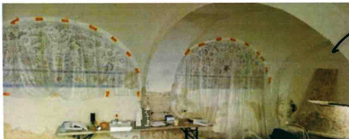
Obr. 5. Dekorácie v čelách dvoch klenieb kryté v priebehu stavebných prác plastovou fóliou.
