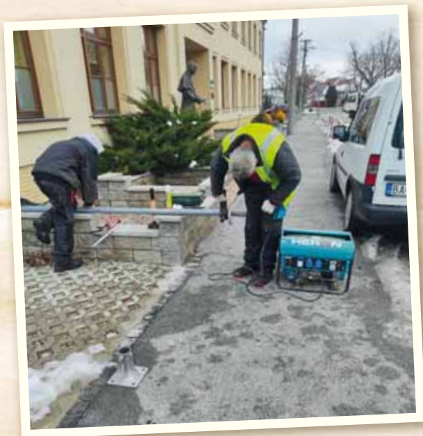
Aj opravy poškodeného značenia patria do činností chlapov z HS
