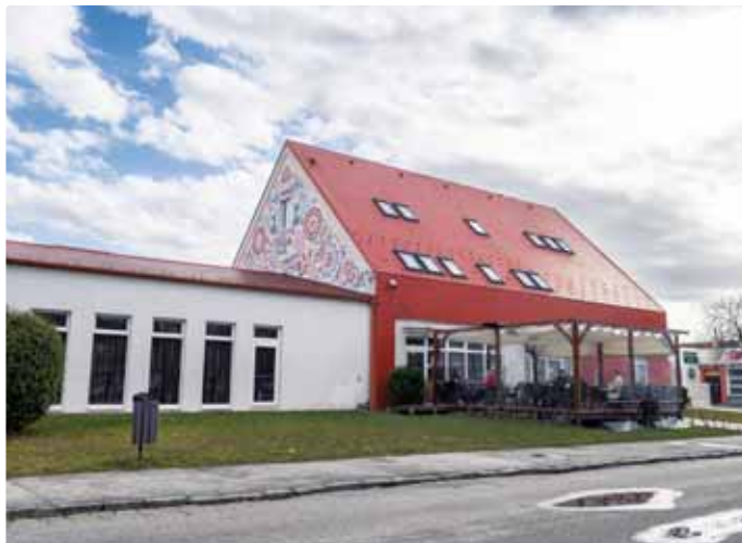
Oblúbený Kultúrny dom vo Vajnoroch prešiel výraznejšou rekonštrukciou naposledy v roku 2015
