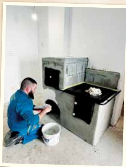
V ľudovom dome pribudla nová stavaná pec
