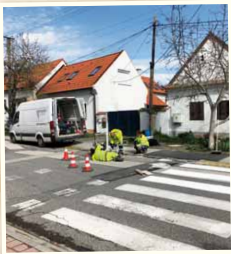
Magistrát začal s obnovou priechodov pre chodcov
