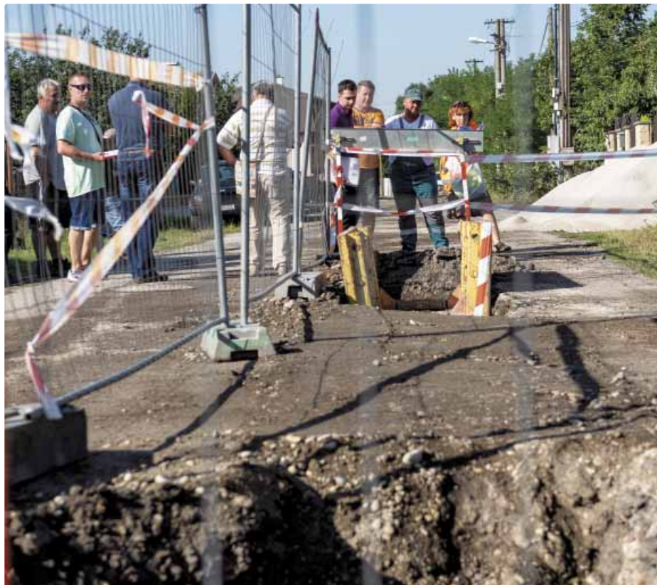
Kontrolný deň na stavbe vodovodu Za humnami, 20. 8. 2020.
