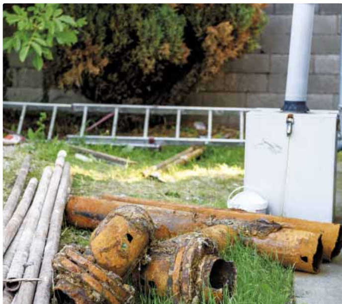
Komponenty z čerpacej stanice
