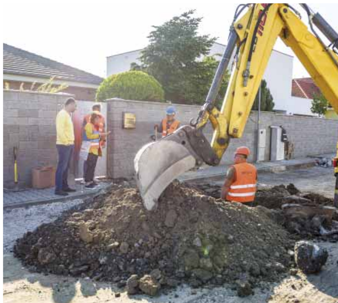
Rozkopávka Širokej ulice
