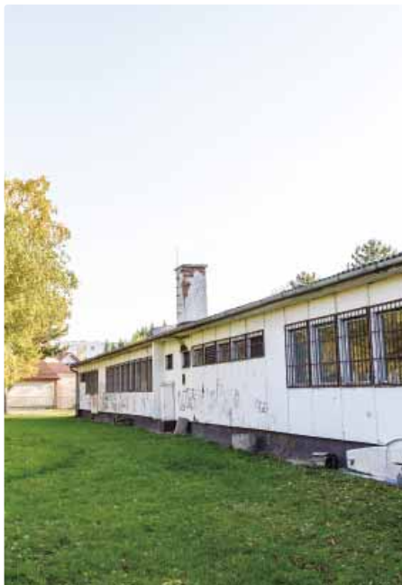
Súčasný stav budovy je už nevyhovujúci
