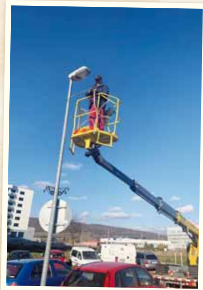
Osadenie vianočného osvetlenia na Rybníchej
