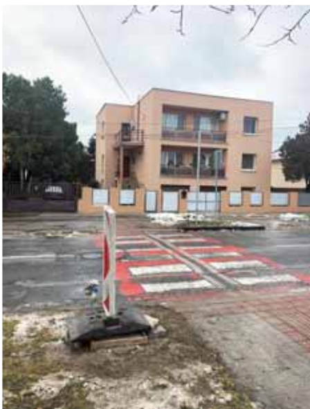
Prípravné práce na osvetlenie chodníka na Rybníckej
