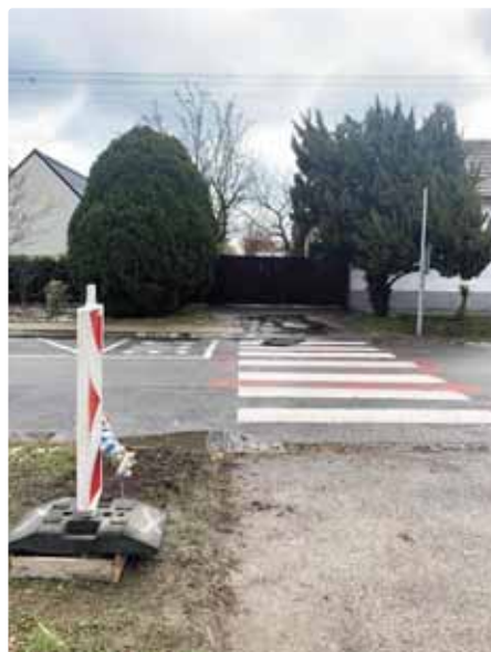
Priechod na Roľníckej pri Hospodárskej ulici bude taktiež osvetlený
