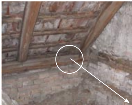
Ilustračné znázornenie približnej pozície dočasných ťahadiel nad klenbou v podkroví domu.
