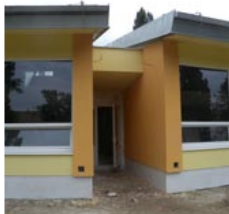
Materská škola dostala novú fasádu.
