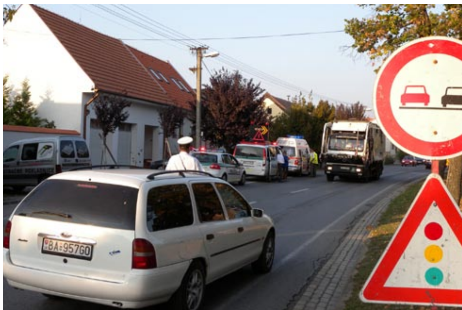
Na Roľníckej ulici sa kladie kanalizačné potrubie. Rozkopávky spôsobujú aj kolízne dopravné situácie. Treba však mať trpezlivosť, veď práce by mali byť hotové do konca roka a kanalizácia bude na prospech celej obce.
