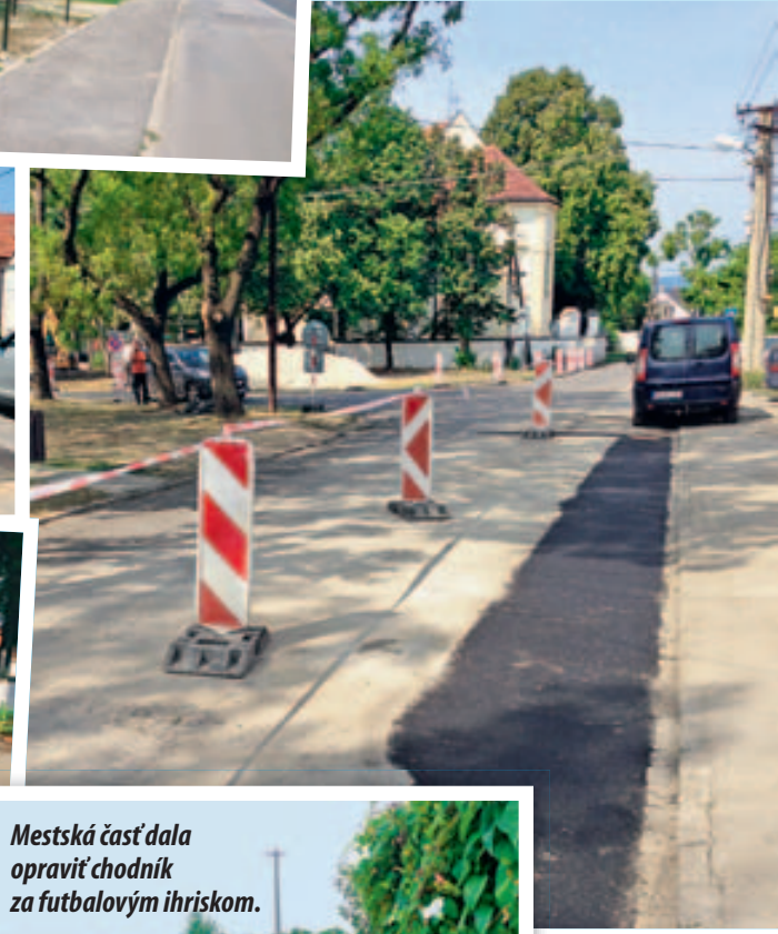
Uloženie nového potrubia dažďovej kanalizácie so zaústením do zbernej šachty v križovatke ulíc Baničova a Osloboditeľská.
