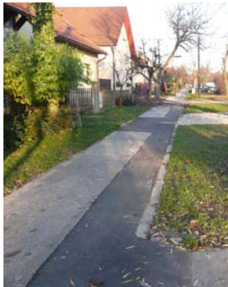
Fotografia novozasiatej trávy v úseku, kde sa robila v lete kanalizácia – tráva vyrástla a aj ružičky pred domom sú pekné.
