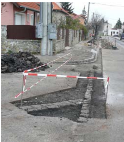
Výstavba dažďovej kanalizácie na križovatke K. Brúderovej a Zátureckého.
