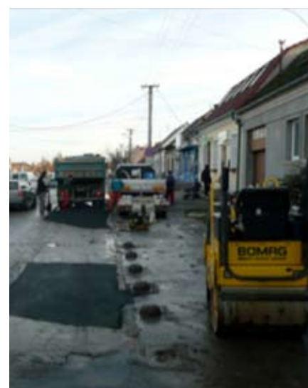
Opravy výmoľov na Šošovkovom námestí pred Hankerom.
