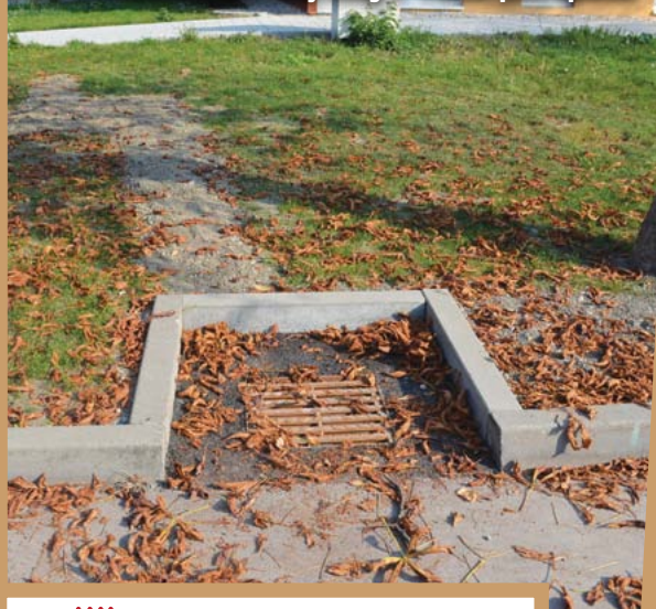
Pri mimoriadnych zrážkach odvedú prívalovú vodu nové zberače dažďovej vody v Parku pod lipami.
